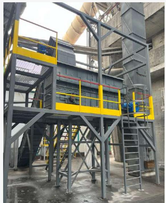
**Назначение системы** – точная дозированная подача RDF топлива в декарбонизатор цементного завода.
